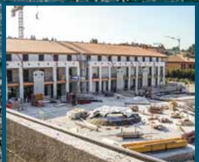
JAHR 2000 BAUSTELLE HOTEL CAESIUS
